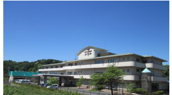
施設の全景（3階建）
